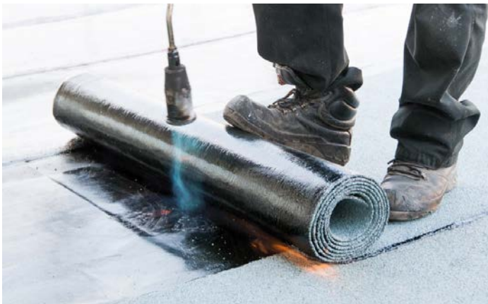
Auf den Gefälleelementen wurde als spezielle Trennlage eine Kaltklebbahn verlegt. Hierauf wurden die Bitumenbahnen geschweißt.
